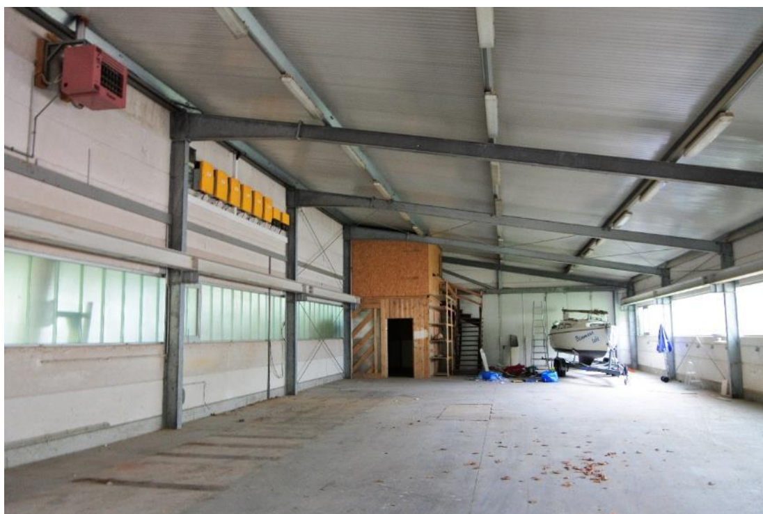
Abbildung 22: Aspekt des nördlichen Teils des Gebäudes im Südosten der Flurstücke 633/6 und 641/3 von innen, alle Fenster sind verschlossen [Foto: BGNatur].
