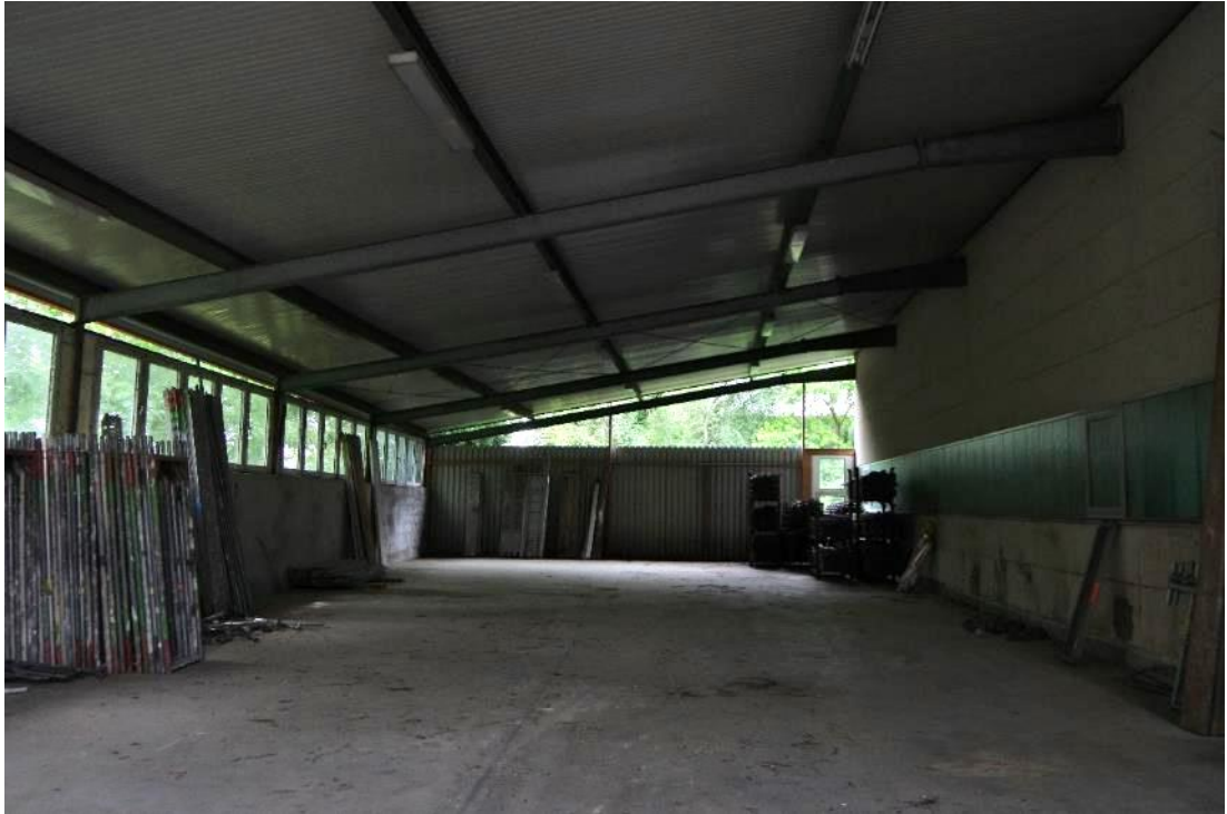
Abbildung 25: Aspekt des südlichen Teils des Gebäudes im Südosten der Flurstücke 633/6 und 641/3 von innen, dieser ist dauerhaft nach oben geöffnet [Foto: BGNatur].
