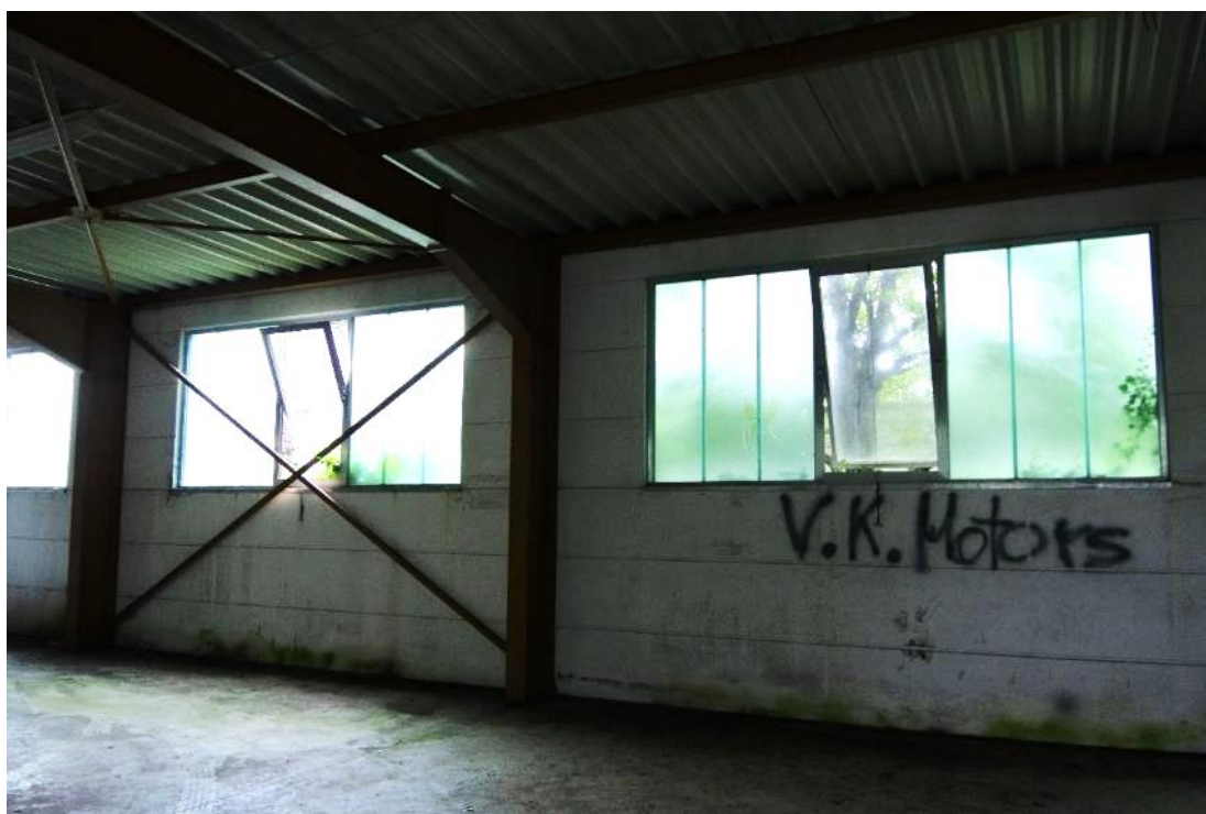
Abbildung 10: Aspekt des Innenraums der Halle auf Flurstück 633/8, nach endgültiger Räumung und Einstellung des Betriebes, sind die Fenster zu verschließen [Foto: BGNatur].
